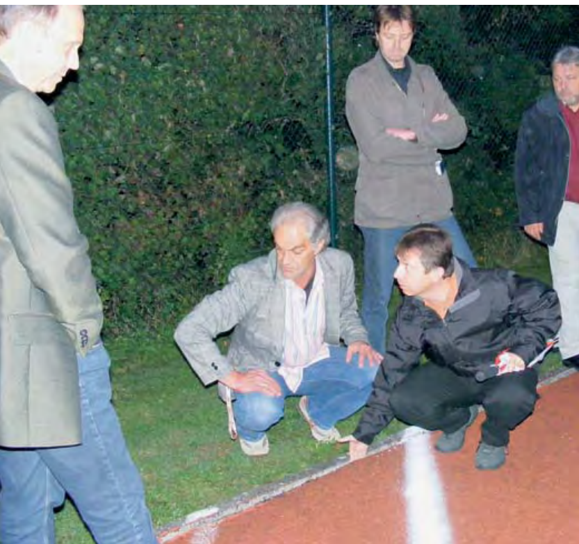
Wo kommen die Risse her? Ein Bodengutachten soll die Gründe für den schlechten Zustand der Laufbahnen klären. Foto: Berger
